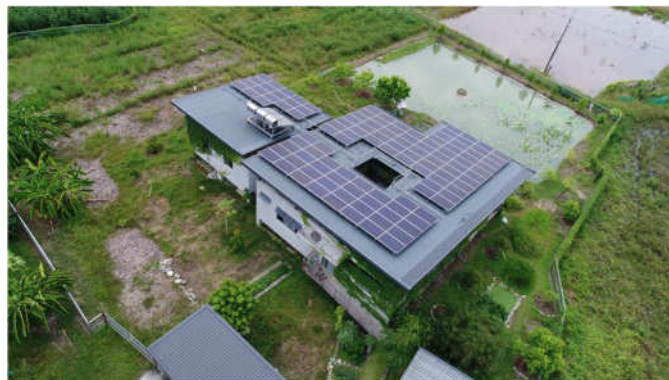
住宅屋頂-王家綠能宅 台南
