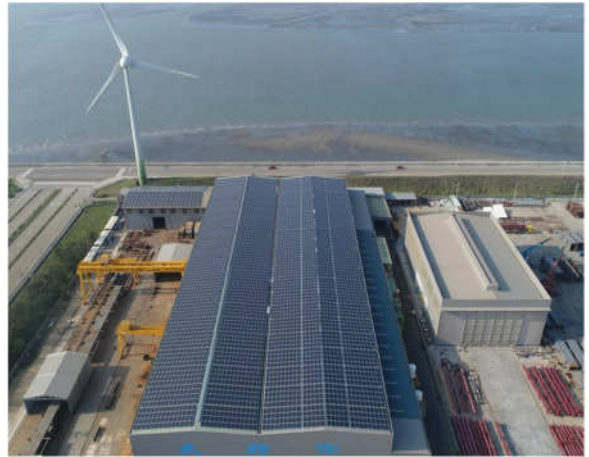
企業廠房屋頂-大將作工業股份有限公司
