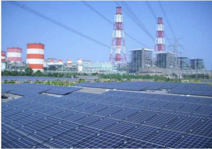
地面型電廠-台灣電力公司 興達港電廠
