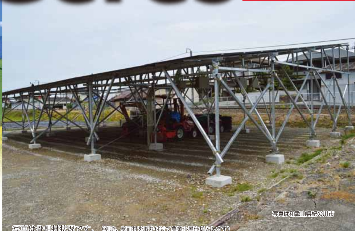
写真は骨組材状況です。（別途、壁面材を取り付けて農業小屋仕様とします）
